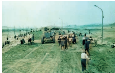
윤중제 공사 현장(1968)
