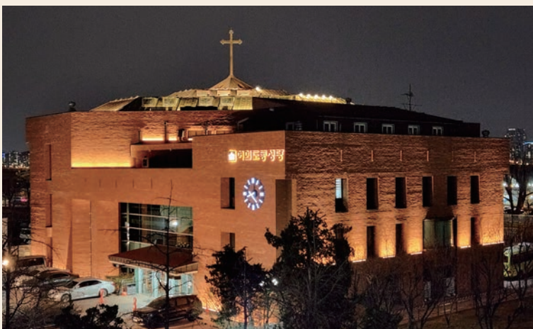
2024. 4. 10. 성당 외벽 조명 공사
