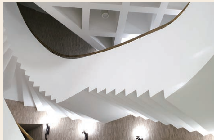
2019. 10. 본당 환경 개선 공사
