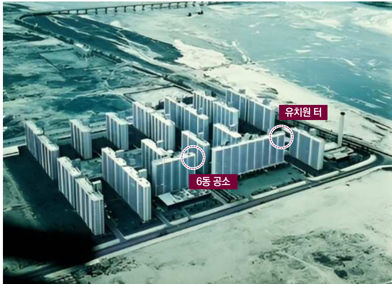
여의도 유치원 터와 시범아파트 6동 공소(1971)
