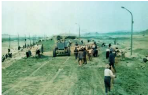
윤중제 공사 현장(1968)
