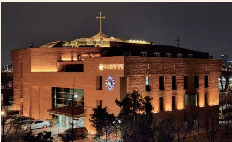
2024. 4. 10. 성당 외벽 조명 공사
