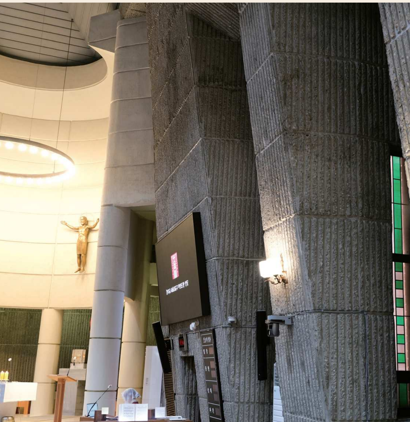
대성전 벽 _ 예수님의 돌무덤을 표현하기 위해 노출콘크리트 공법(루돌프 콘크리트 공법) 사용 콘크리트로 마감 후 표면을 다시 조각하여 자연 암석과 같이 처리
