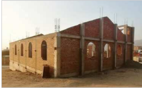
페루에 건설 중인 공소(2024)
